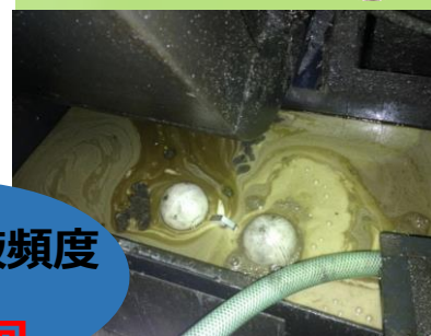
浮上油が溜まった現場
